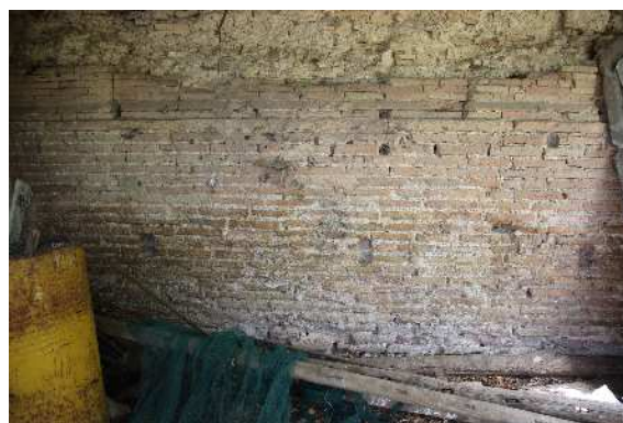
Fig. 15. Montebuono, Fianello. Resti di monumento sepolcrale in opus latericium inglobato in un casolare moderno (foto V. Bruni).
