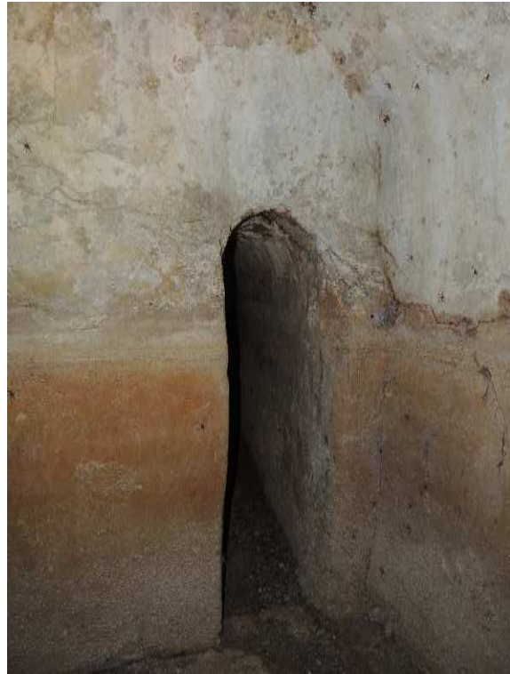
Fig. 19. Fianello, Santa Maria Assunta. Speco dell'acquedotto inglobato nella costruzione moderna dietro il fontano (foto F. Colosi).
