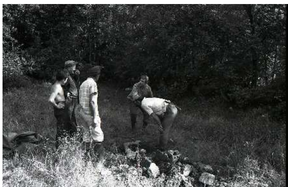
Fig. 14. La scoperta dell'acquedotto nel 1969 (foto F. Mastrodicasa Rinaldi, Archivio Comune di Cottanello).
