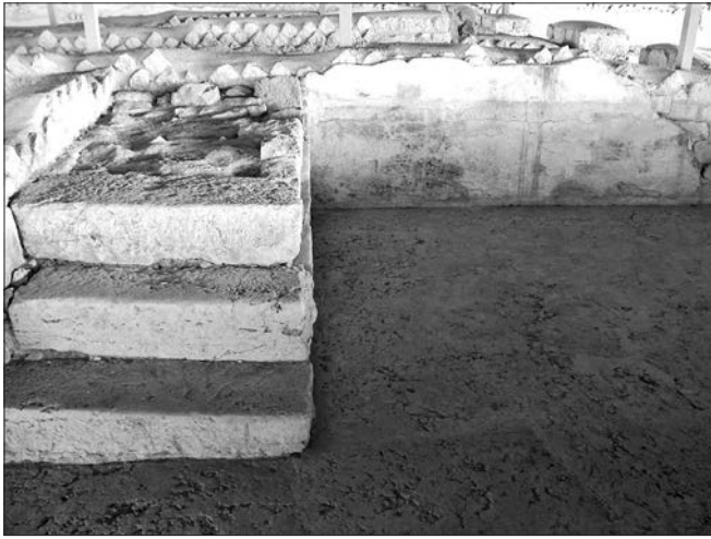
Fig. 9. - Ambiente 5: pavimento in cementizio.
