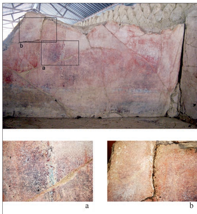
Fig. 1. - Ambiente 9, parete 9,3a; a) parete 9,3a, particolare del colore azzurro/verde; b) parete 9,3a, particolare di una fratturazione dell'intonaco.
