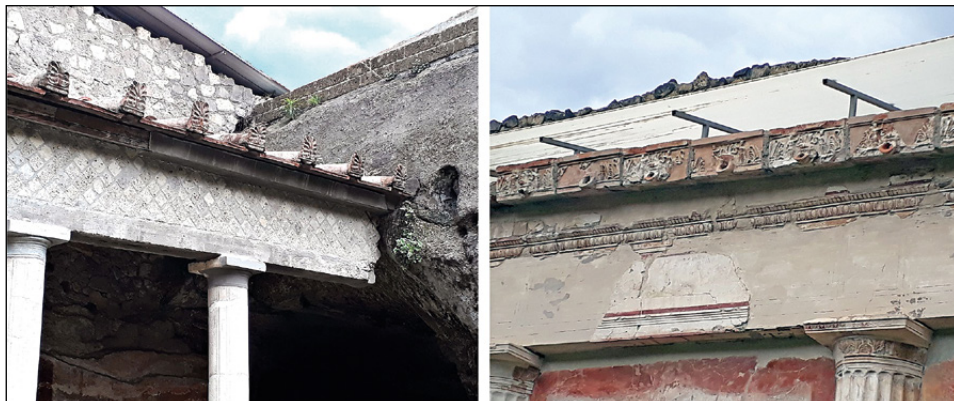
Fig. 5 – Villa A di Oplontis, la decorazione architettonica fittile in situ .
